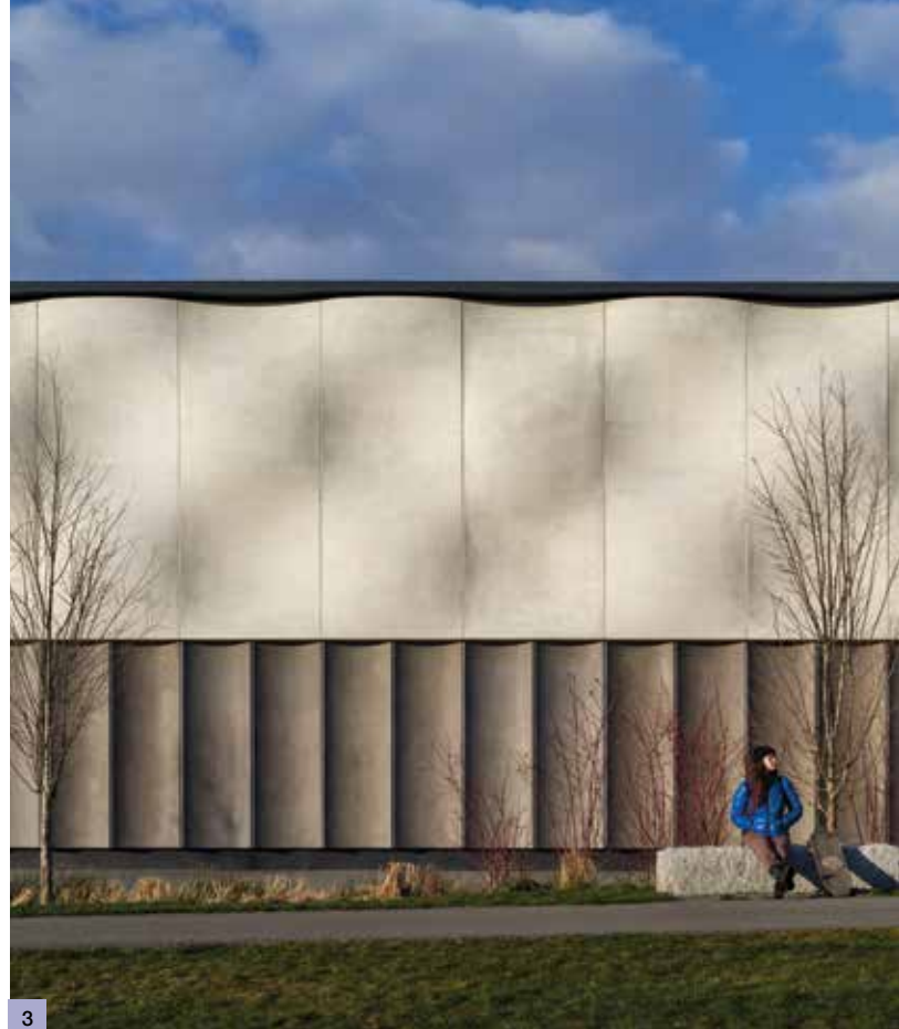
3. The abstract undulating wave patterns of the precast concrete panels communicate the purpose of the reservoir and provide further visual appeal of changing light and shadow patterns during the day. / Les patrons de vagues ondulées des panneaux de béton préfabriqué permettent d'exprimer la raison d'être du réservoir. Ils rehaussent aussi l'aspect visuel de l'ensemble avec des jeux de lumière et d'ombre qui changent constamment au courant d'une journée.
