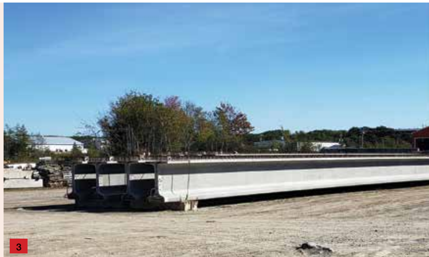
3. Precast prestressed concrete bridge girders in Strescon's yard, waiting for "Just in Time Delivery". / Poutres de pont précontraintes préfabriquées en béton (NEBT) dans la cour de Strescon, en attente d'une « livraison juste à temps ».
