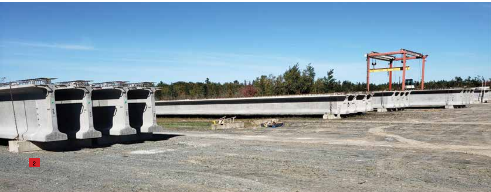
2. Long span precast prestressed concrete bridge girders. / Poutres de pont précontraintes de longue portée préfabriquées en béton.
