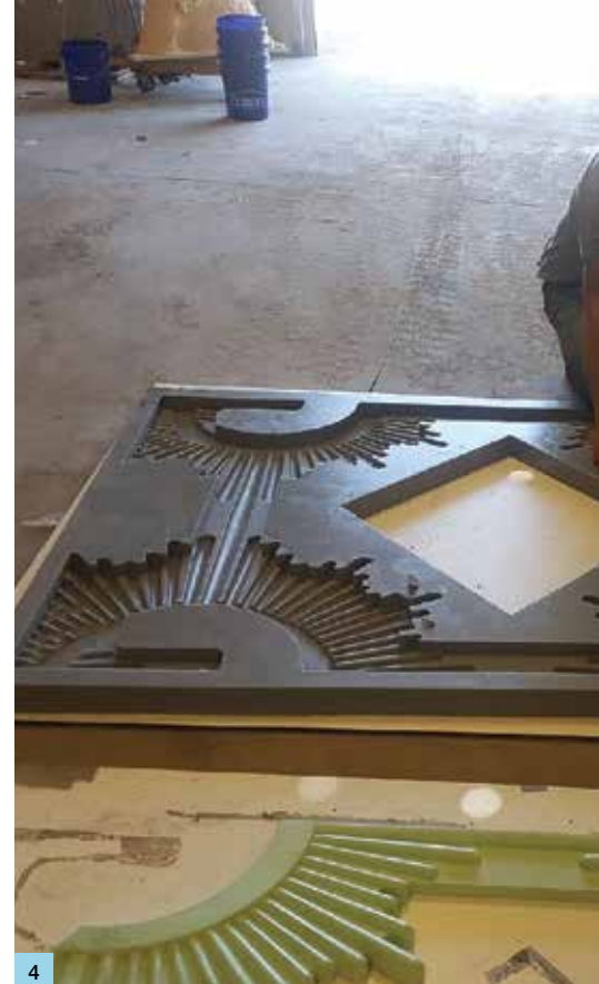
4. Using the CAAST® system, rubber was used to create the working moulds. / À l'aide du système CAAST®, le caoutchouc a été utilisé pour créer les moules qui ont servi à la fabrication des panneaux de mur.
