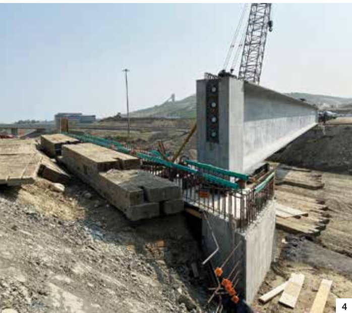
NU girder sizes used on the North Project/ Dimensions des poutres NU utilisées dans le Projet nord
